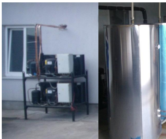
Рисунок 3. – Компрессорно-конденсаторный агрегат с системой регулирования холодопроизводительности и рекуператором тепла
