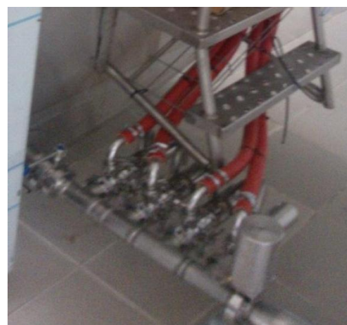
Рисунок 5. – Коллектор для подключения охладителя молока к доильным роботам
