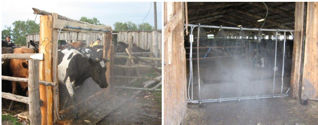
Рисунок 2. – Универсальная установка для опрыскивания животных
