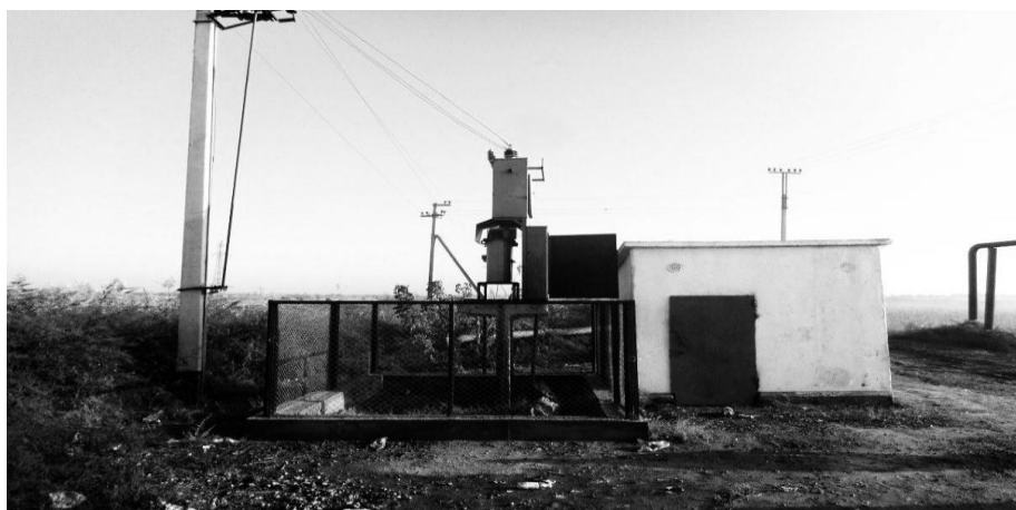
Рисунок 5. – Скважина вертикального дренажа на пилотном участке
