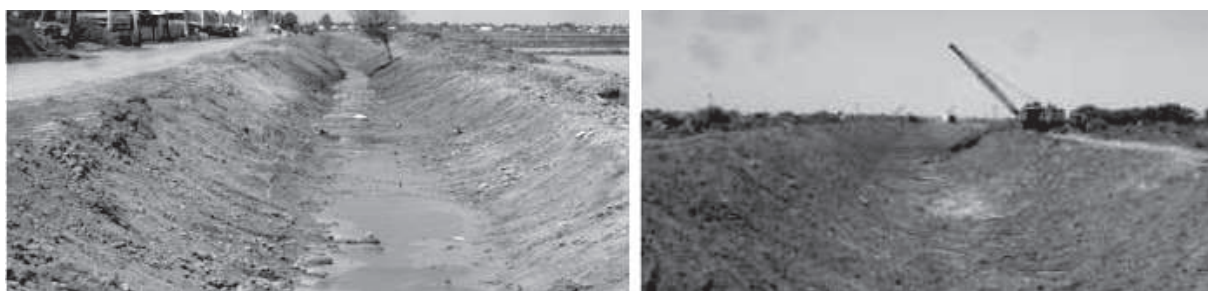
Рис. 1. Каналы после ремонтно-очистительных работ
