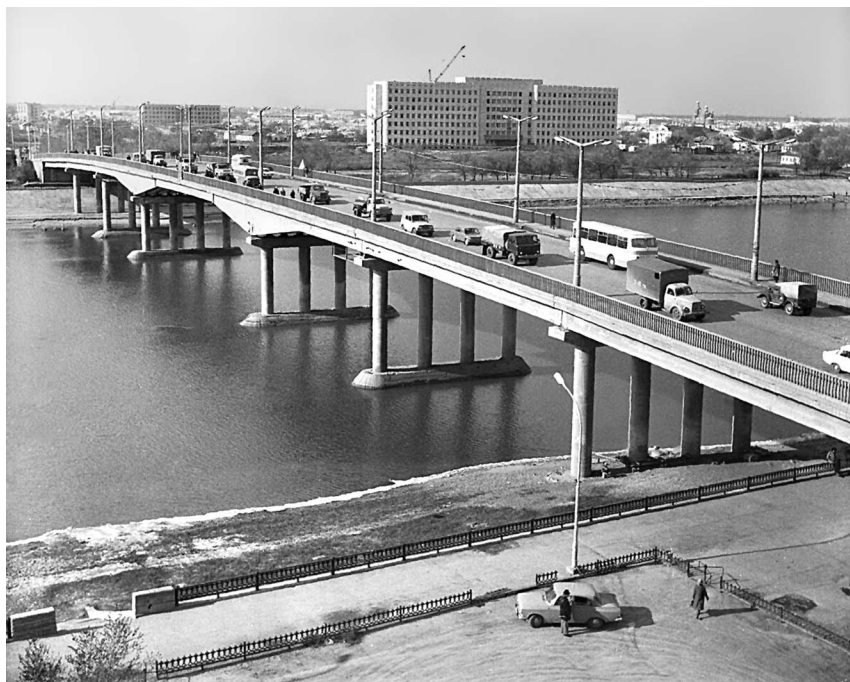
Капитальный мост через реку Урал
