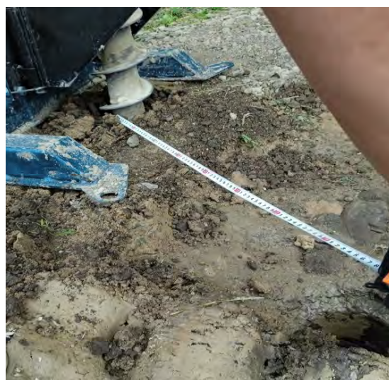
Рисунок 79 – Замеры расстояния между контрольными лунками бурения скважин
