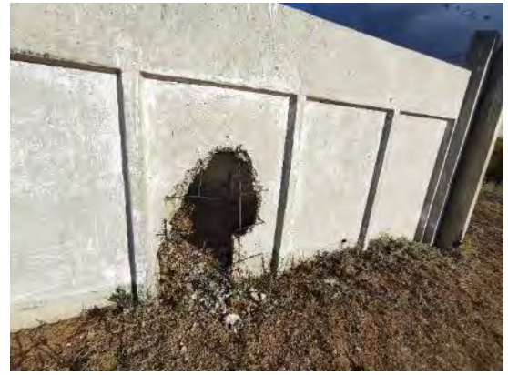
Рисунок 58 – Ограждение почвенного очага в Бухар-Жырауском районе Карагандинской области (с западной стороны нарушена целостность бетонной плиты)
