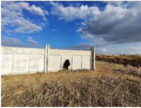
Рисунок 58 – Ограждение почвенного очага в Бухар-Жырауском районе Карагандинской области (с западной стороны нарушена целостность бетонной плиты)
