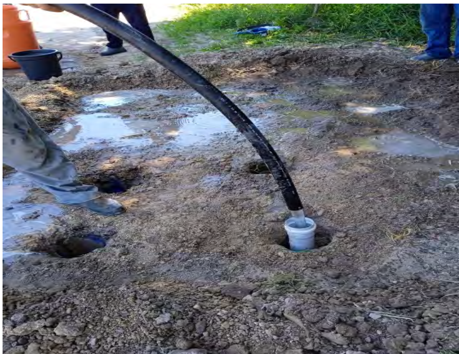
Рисунок 77 – Заполнение скважины водой с использованием пластиковой трубы
