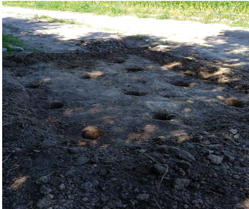
Рисунок 76 – Подготовленная опытная площадка с 12 скважинами
