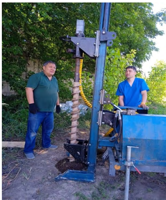
Рисунок 74 – Контрольное бурение скважины для определения естественной влажности почвы и наличия грунтовых вод
