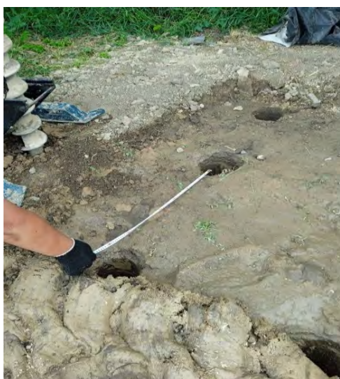
Рисунок 79 – Замеры расстояния между контрольными лунками бурения скважин
