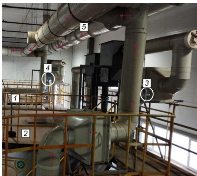
Рисунок 2 – Расположение точек отбора проб для оценки состава ОГ ферментера: 1, 2 – ферментеры; 3, 4 – точки отбора проб; 5 – система транспортировки ОГ.
