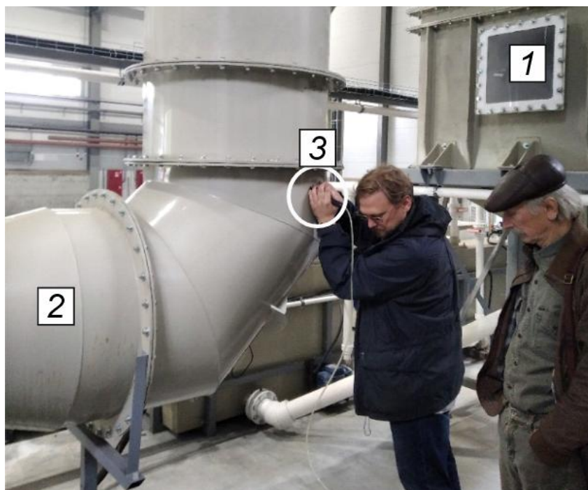
Рисунок 3.3 – Ввод ОГ в скрубберный зал 1 – скруббер, 2 – система транспортировки ОГ, 3 – контрольная точка №7
